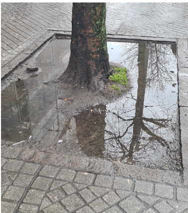
Abb. 14: Versickerungsfähige Baumscheibe
